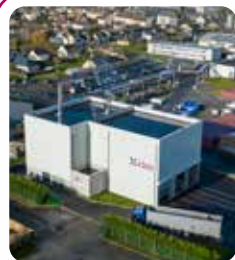
Mise en service d'une centrale de production de vapeur décarbonée pour l'usine Bel d'Evron
