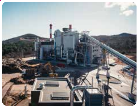
Acquisition de Sylvania , centrale de production d'électricité à partir de biomasse à Brignoles
