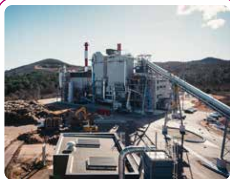
Acquisition de Sylviana , centrale de production d'électricité à partir de biomasse à Brignoles
